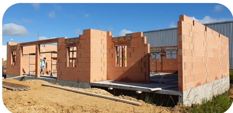
Construction d'un cabinet de kiné dans la zone d'activités
